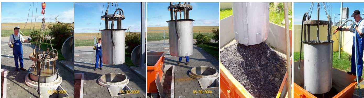
Usuwanie osadu z osadnika Gesmo
